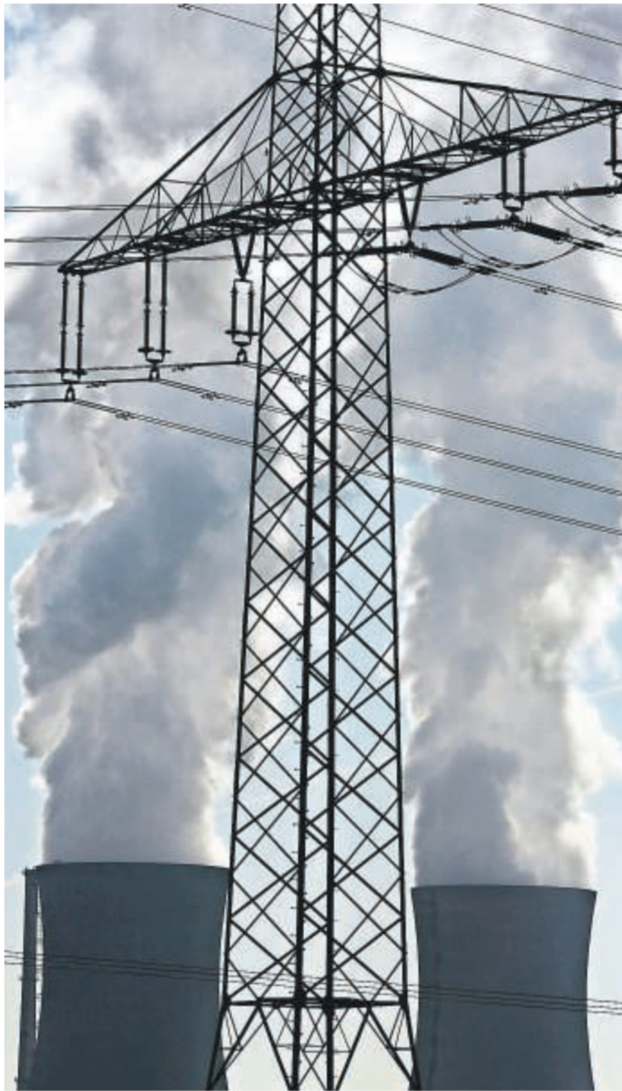
Ein Strommast vor den dampfenden Kühltürmen des Atomkraftwerkes Grafenrheinfeld in Unterfranken. Foto: dpa
