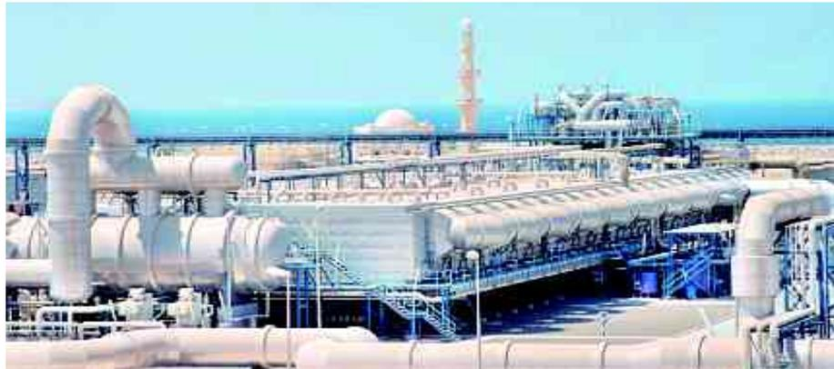
Das der Entsalzungsanlage benachbarte 1500MW- Gasturbinenkraftwerk Shuweihat liefert den Anzapfdampf für den Betrieb. Im Endausbau sollen täglich 1,4 Mio.m<sup>3</sup> Trinkwasser hergestellt werden.
